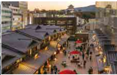
地上14階、地下1階のタワー棟と江戸情緒漂う「小田原新城下町」からなる「ミナカ小田原」。JR小田原駅改札から徒歩3分。小田原駅東口直結の連絡通路から雨にぬれずに行くことができます
