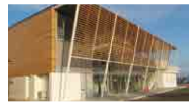
竣工した大磯港賑わい交流施設「OISO CONNECT(オオイソコネクト)」。延べ床面積約1006.31㎡、鉄筋コンクリート造
