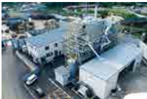
新設された発電所は、蒸気タービン方式を採用(出力は1990Kw、年間発電量1420万Kw)
