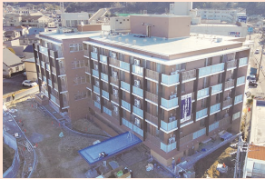
鉄筋コンクリート造の地上5階建て（土地・建物／非所有）、全100室すべてが個室の「サニーステージ北鎌倉」（建設中、2024年1月撮影）
